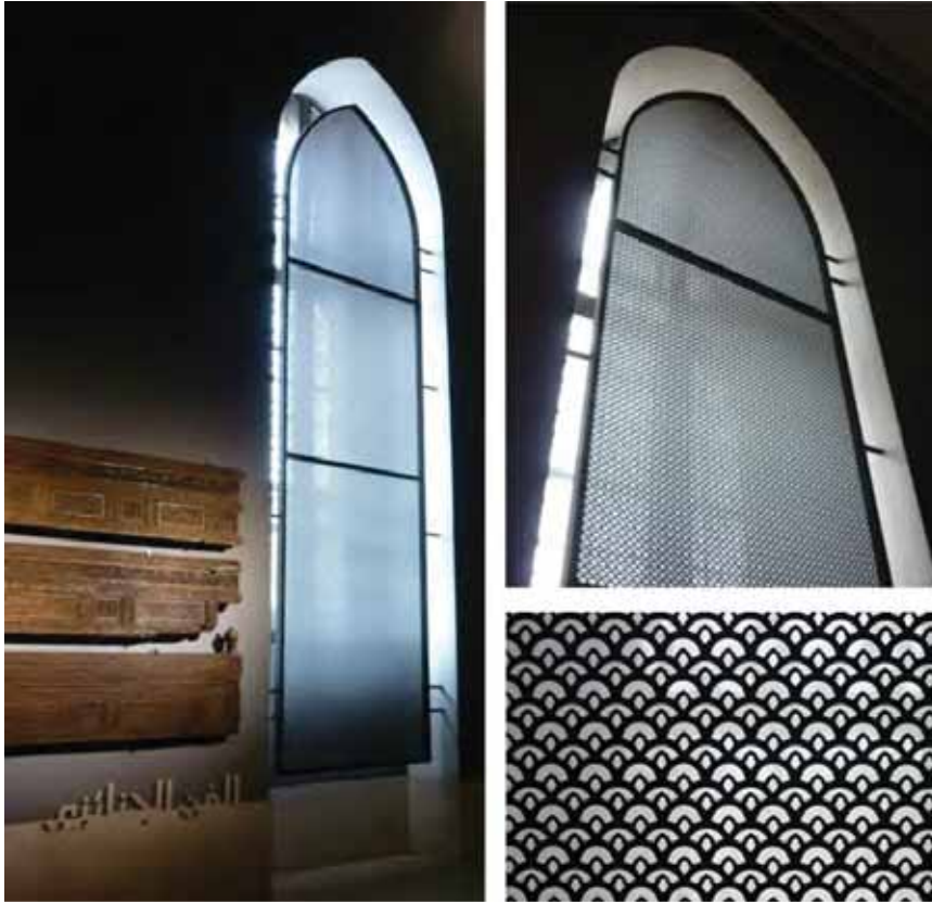
شكل ( ٣-٨٧): الوحدات الداخلية المظله التي تساعد في التقليل من الأشعا الشمسي الواقع على النوافذ (المصدر: الباحث)
