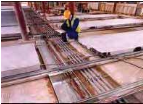
شكل ( 3-57) : استخدام المياه الجوفية في عمليات تبريد المبنى
