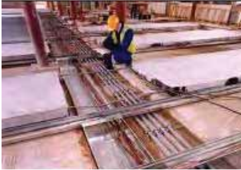
شكل ( ٣-٥٢): شبكة المواسير تحت الأرض ( Under floor pipework) التي تعمل على تبريد بلاطة الارضية بأستخدام المياه الجوفية المصدر ( http://projects.bre.co.uk/envbuild/envirbui.pdf )
