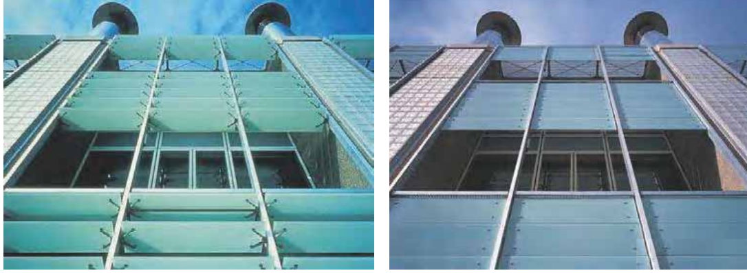
شكل ( ٣-٤٩): شكل يوضح تغير اتجاهات الشرائح الزجاجية الدوارة (Rotting glass louvers) حسب وضع الشمس (المصدر: Michael Wigginton and Jude Harris, "Intelligent Skins")
