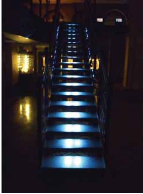
شكل ( ٣-٧٤ ): استخدام وحدات أضواء موفرة للطاقة (LED Unit) في اضاءة السلالم الداخلية لقاعة العرض (المصدر: الباحث)
