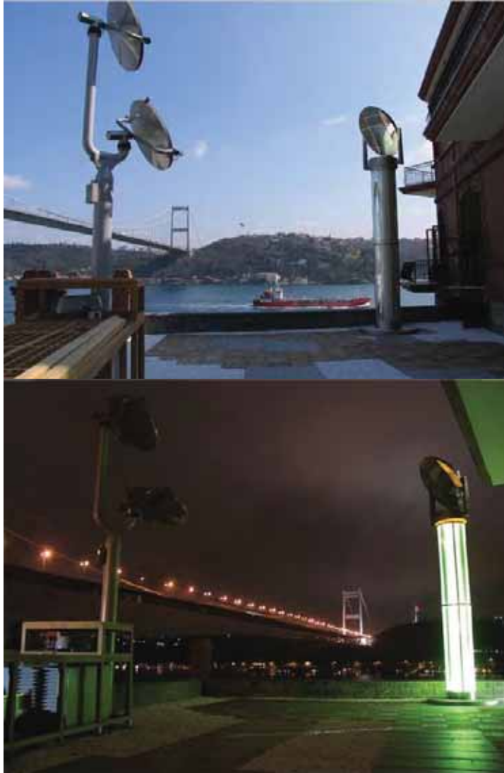
شكل (٣-٢٣): يوضح استخدام الهليوستات يعمل بطريقة (Sun Beam) فى فترات مختلفة من ساعات اليوم
