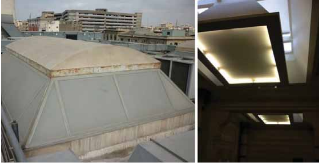
شكل ( ٣-٦٧): إلى اليمين: الوحدات السقفية من الداخل ولكنها لا تؤدي الغرض منها حيث يتم أستعمال الأضاءة الصناعية بالرغم من وجودها- إلى اليسار: الوحدات السقفية من أعلى المبنى (المصدر:الباحث)
