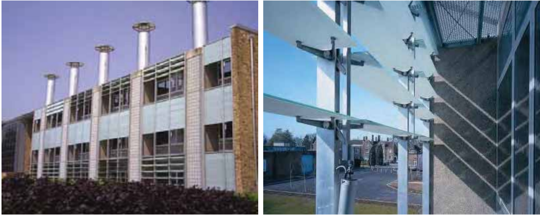
شكل ( ٣-٤٨ ): الشرائح الزجاجية الدوارة (Rotting glass louvers) التي يمكن لها التحكم
