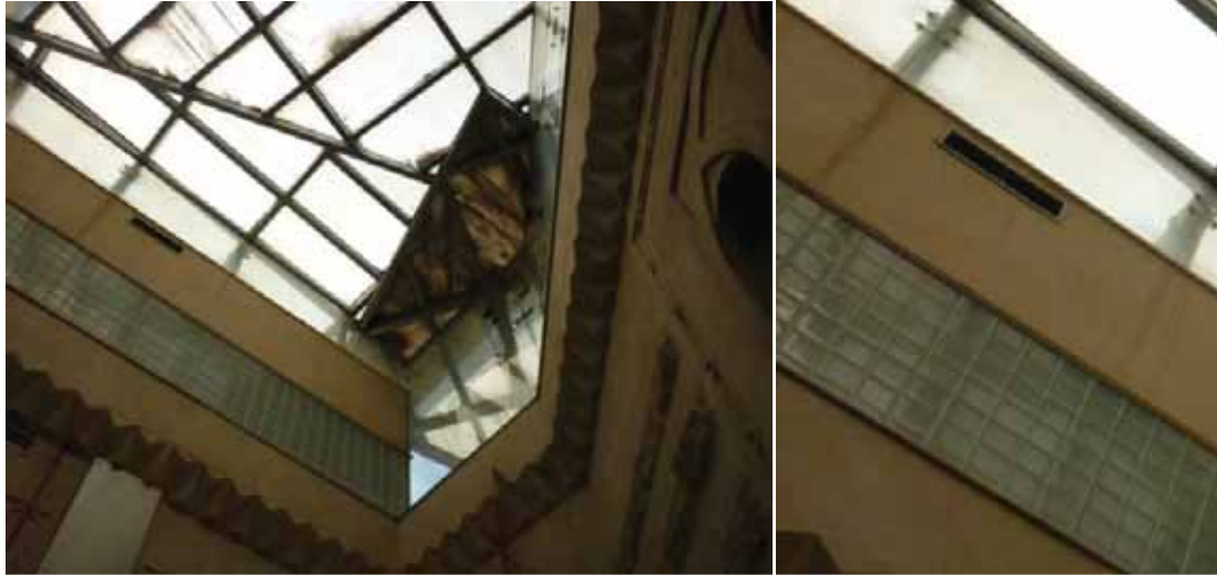
شكل ( ٣-٧٩): عدم استخدام الفتحات السقفية في التخلص من الطاقة الحرارية الزائدة والاعتماد على أنظمة التهوية الصناعية (المصدر: الباحث)
