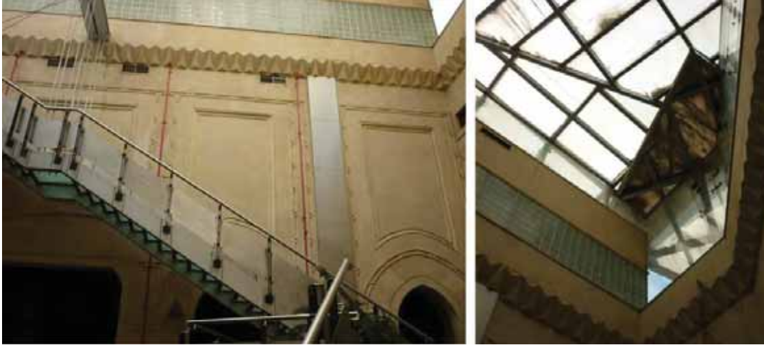
شكل ( ٣-٨٢): إلى اليمين: الفتحات السقفية مغلقة بالكامل ولا يمكن التحكم فيها أو التغيير في ا خواصها - إلى اليسار: استخدام التهوية الصناعية في الفراغ المفتوح (المصدر: الباحث)
